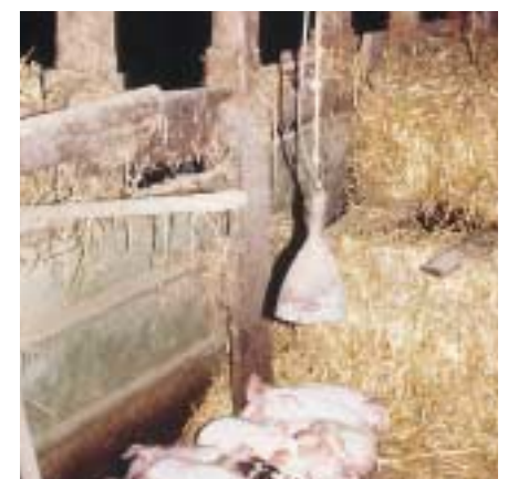
Brandgefahr durch selbstgebastelte Aufhängung und fehlendem Schutzgitter bei einem Elektro-Wärmestrahler
