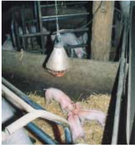
Vorschriftsmäßige Aufhängung eines Elektro-Wärmestrahlers mit Schutzgitter
